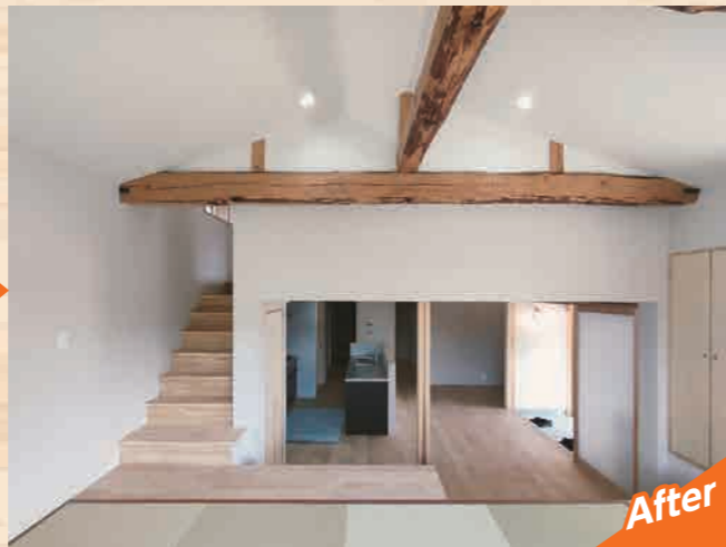
古材の梁を“あらわし”の技法で保存活用されました。
